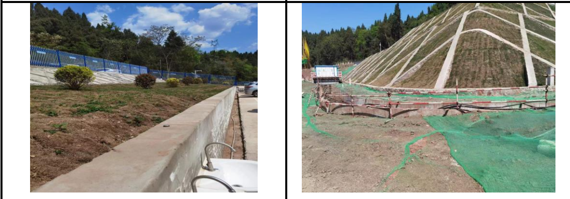
施工营地临时绿化
