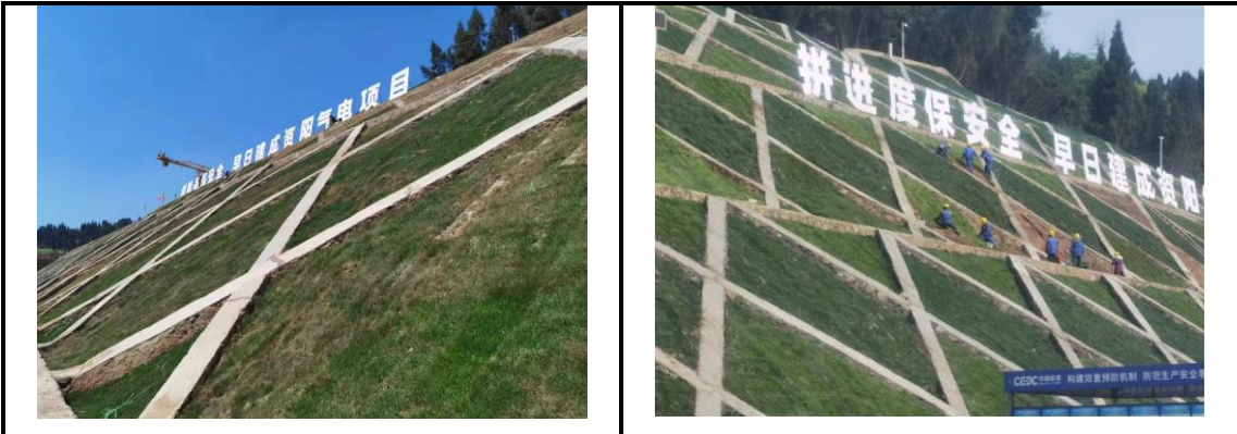
浆砌片石植草皮护坡
