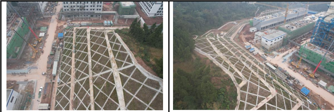
浆砌片石植草皮护坡
