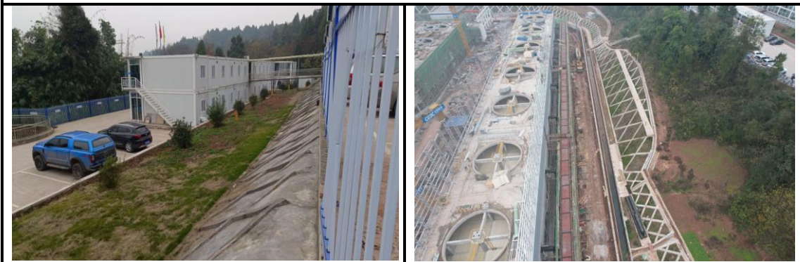
施工营地临时绿化
