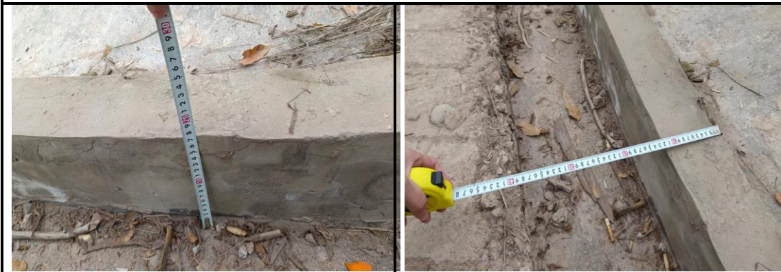
施工营地排水沟
