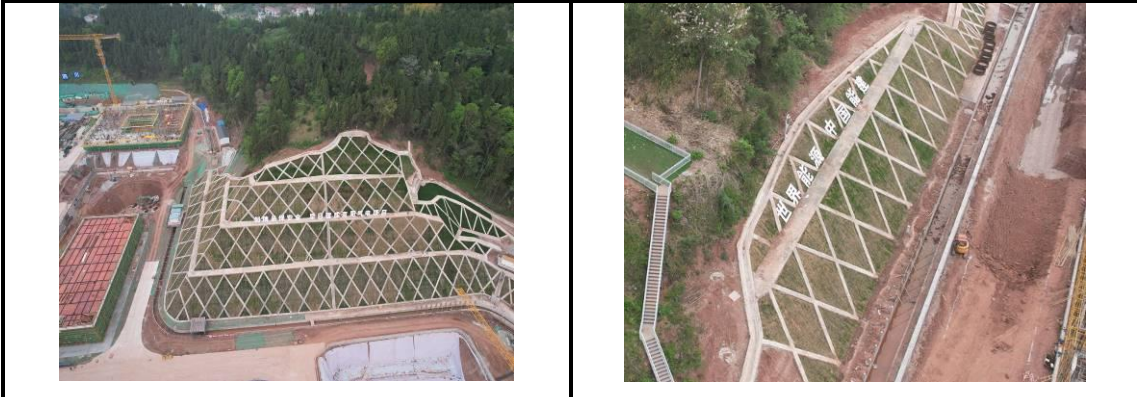
浆砌片石植草皮护坡
