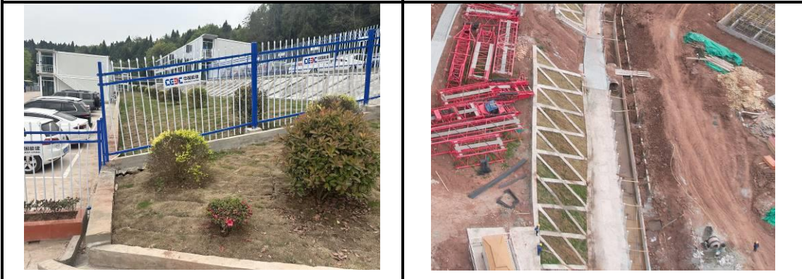
施工营地临时绿化
