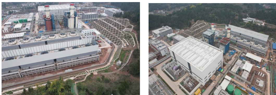
图1-1 厂区施工情况
