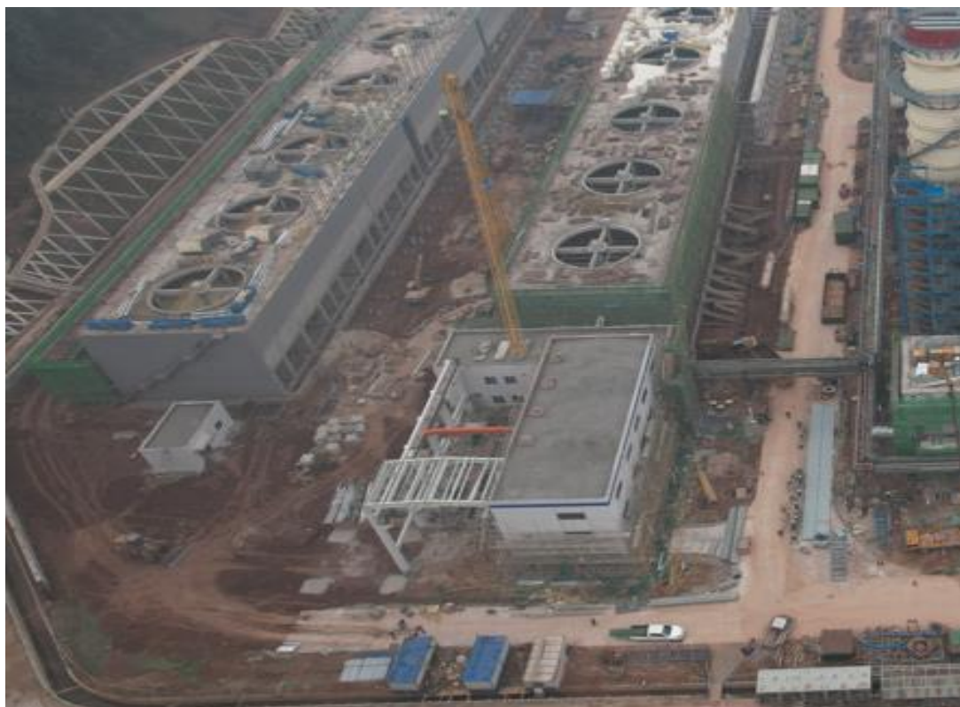
图1-5 表土临时堆放场区现状
