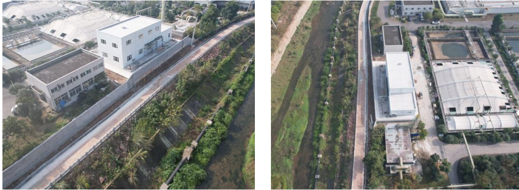
图1-2 取水泵房扰动现状
