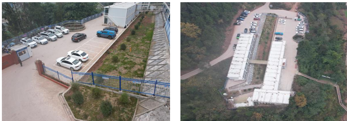
图1-4 施工生产生活设施现状
