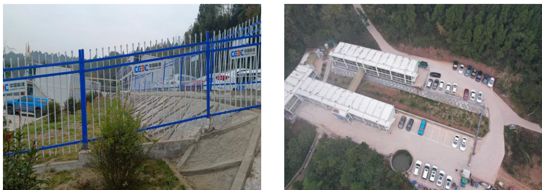
图1-4 施工生产生活设施现状
