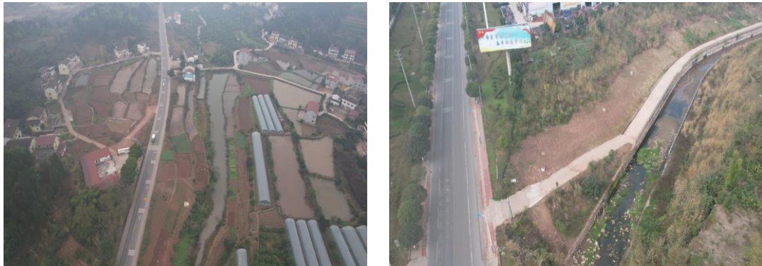
图1-3 取水管线工程区现状
