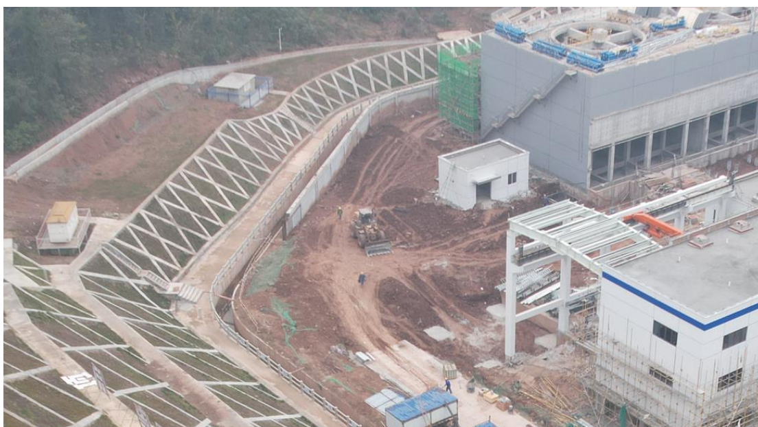
图1-5 表土临时堆放场区现状
