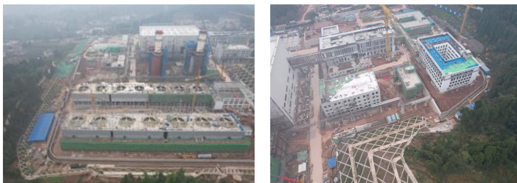
图1-1 厂区施工情况
