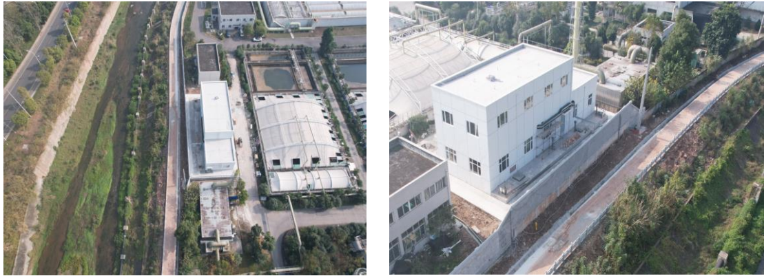
图1-2 取水泵房扰动现状
