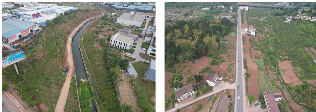
图1-3 取水管线工程区现状
