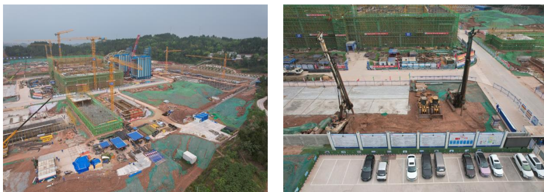
图1-1 厂区施工情况
