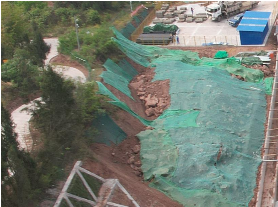
图1-12 表土临时堆放场区现状
