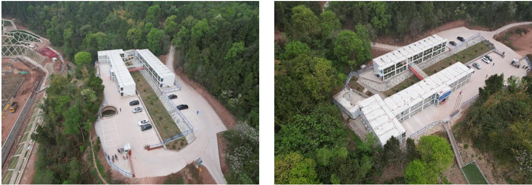
图1-11 施工生产生活设施现状
