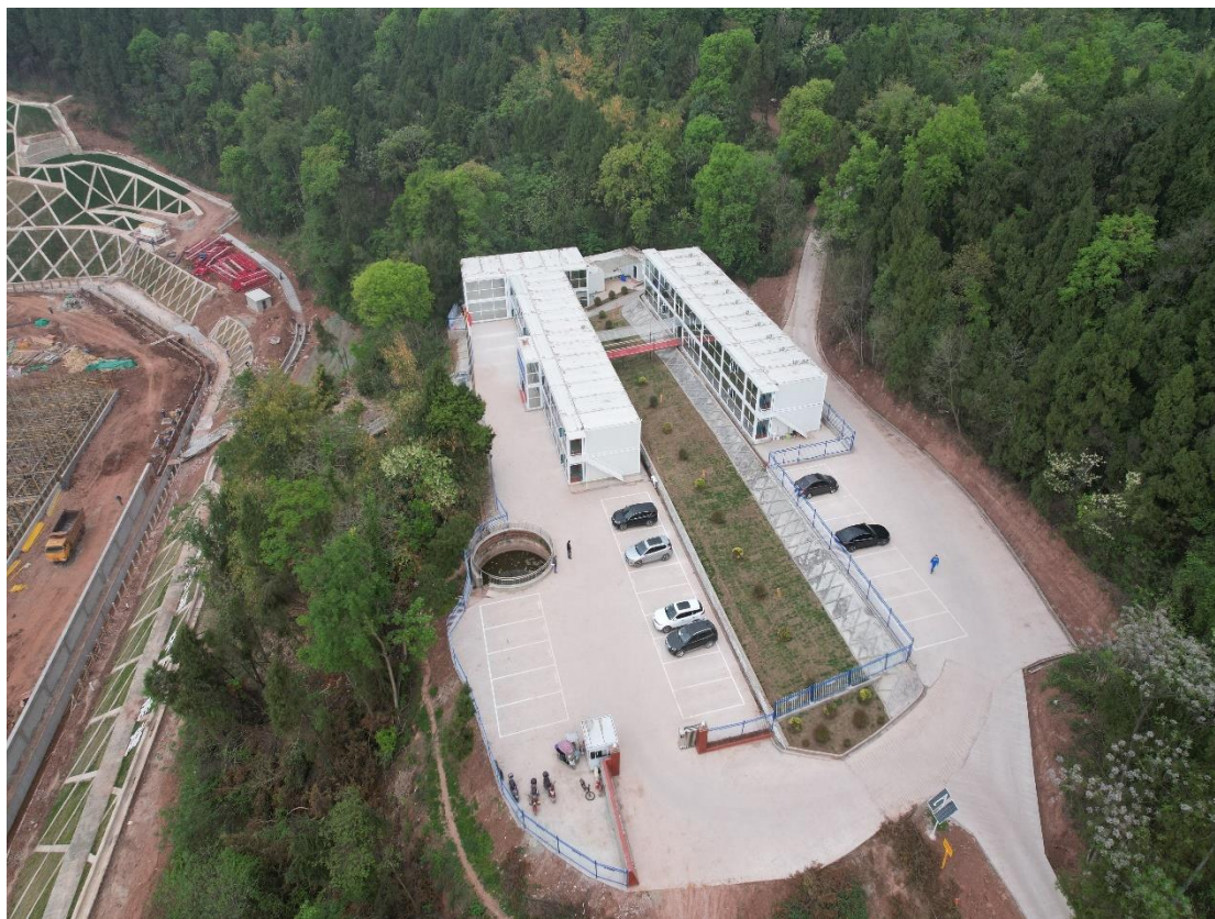
图2-1 现场施工营地及施工项目部
