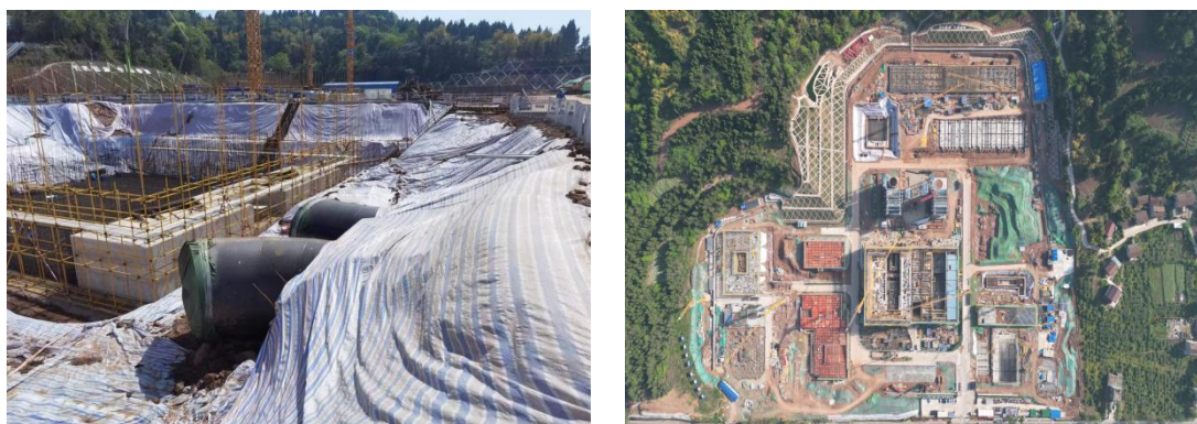
图1-6 厂区施工情况
